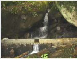
Captação 1 Bom Retiro Baixo
