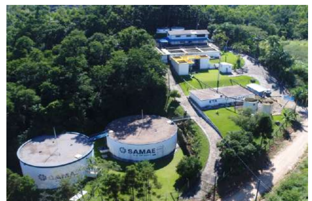
ETA - Estação de Tratamento de Água - Bom Retiro Baixo
