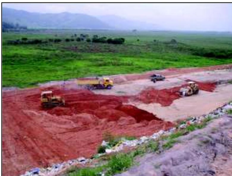
Figura 7.98 - Impermeabilização com 40 cm de Argila compactada
