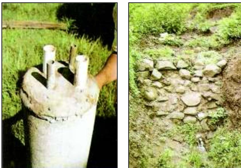
**Figura 8.5 - Protetor de fonte caxambu. Fonte: (EPAGRI, 2010)**
