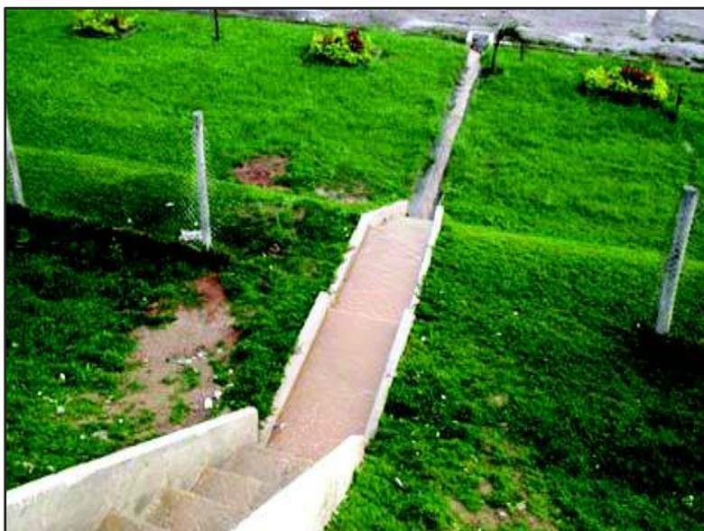
**Figura 7.100 - Drenagem Pluvial do Aterro**
