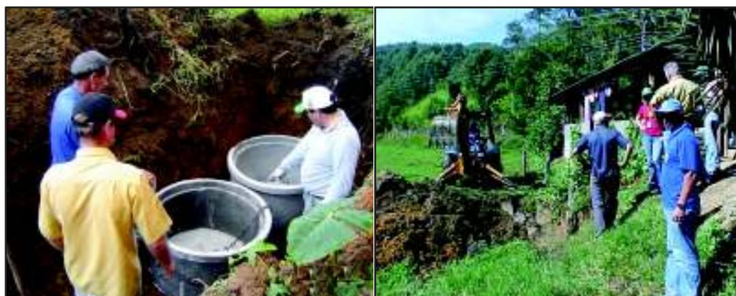
**Figura 7.87 - Instalação do Sistema fossa-filtro na zona rural**
