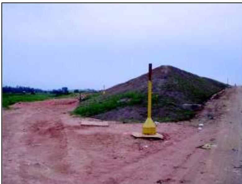
**Figura 7.102 - Sistema de drenagem de gases**
