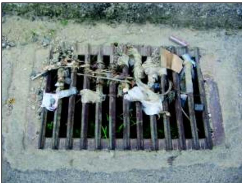
**Figura 7.124 – Falta de manutenção em bocas de lobo de São Ludgero**
