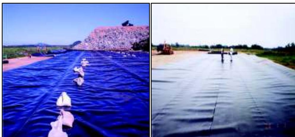
**Figura 7.99 - Mantas de PEAD instaladas no aterro sanitário**
