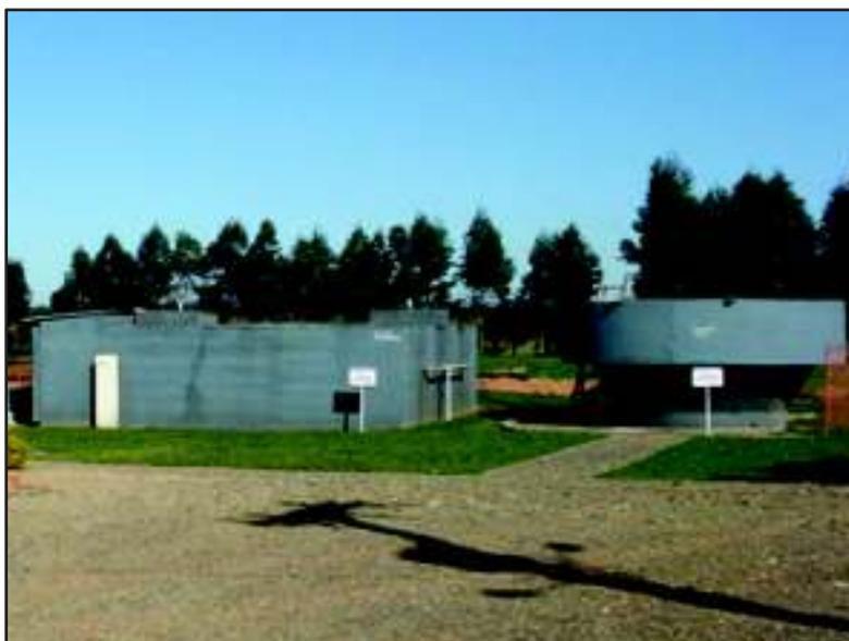
**Figura 7.105 - Filtro Anaeróbio e UASB**
