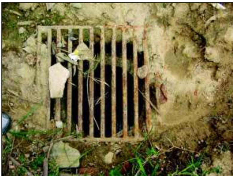
Figura 7.85 - Lançamentos de esgoto na rede pluvial
