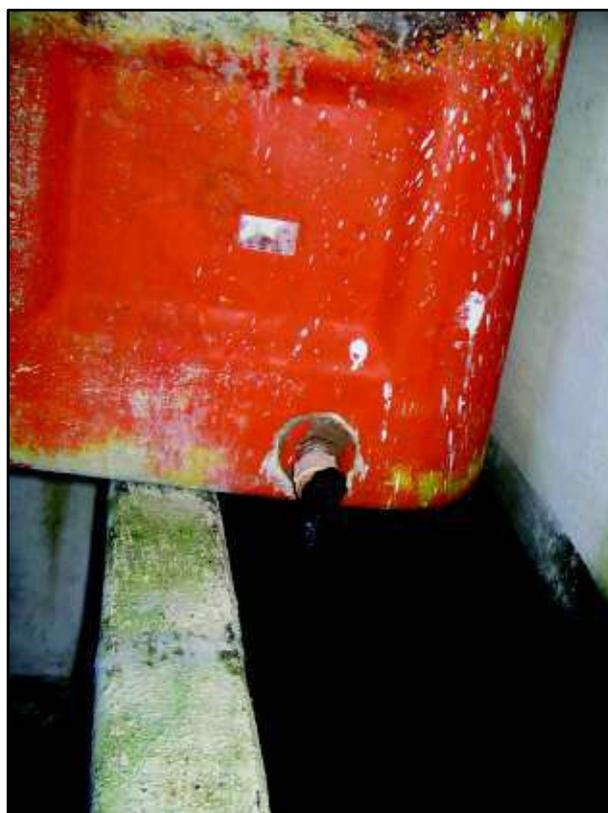
**Figura 7.55 - Aplicação do desinfetante na ETA de Barra do Norte**
