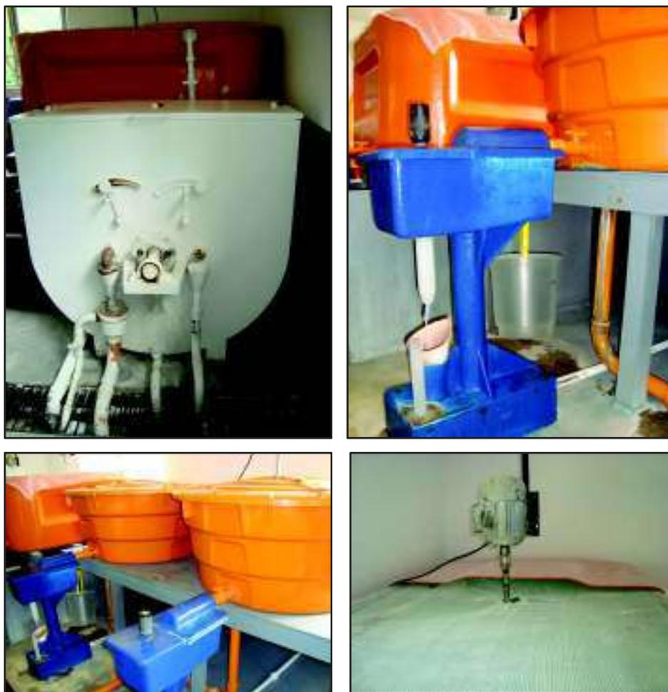
**Figura 7.46 - Dosadores de produtos químicos e agitador mecânico da ETA de São Ludgero**
