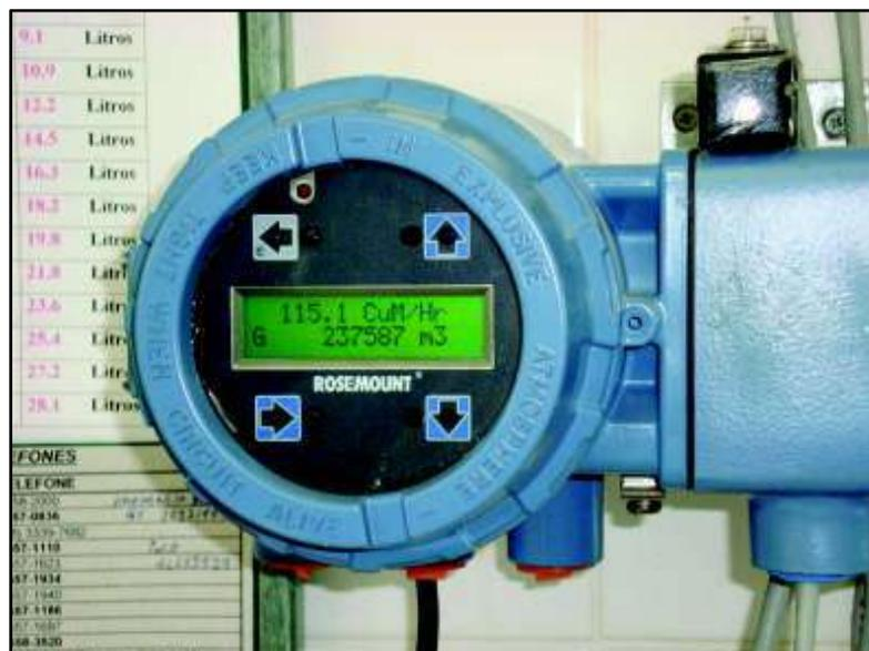
Figura 7.48 - Macromedidor de vazão da ETA de São Ludgero
