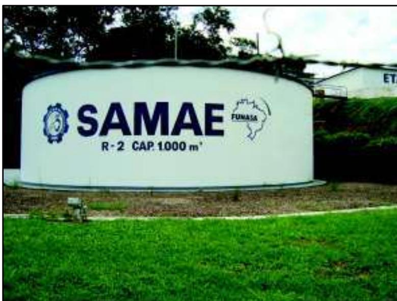
**Figura 7.50 - Reservatório (R2) de distribuição de água tratada**
