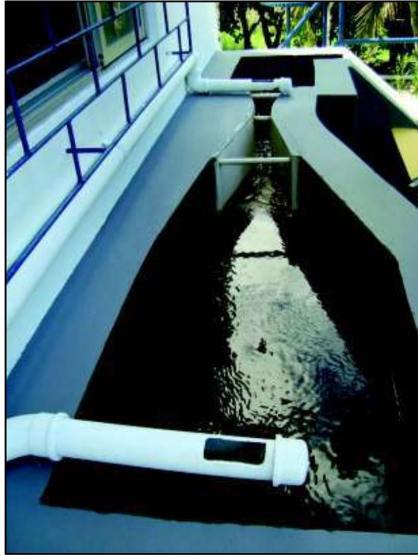
**Figura 7.40 - Chegada da água Bruta – Calha Parshall**
